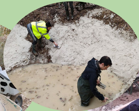
Etanchéification par une couche de bentonite fin novembre 2022
