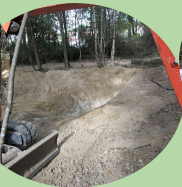
Creusement à 1,50 m de profondeur avec des pentes variables
